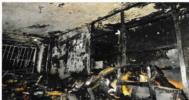
Рис. 3. Термические повреждения квартиры
