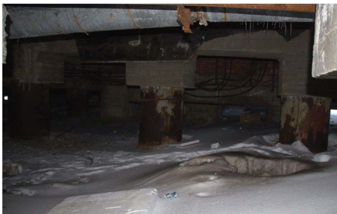
Рис. 1. Буроопускные сваи и металлическая обсадная труба в пространстве вентилируемого подполья (г. Норильск)
