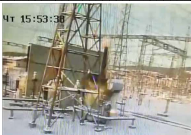
Рис. 4. Возникновение горения реактора
