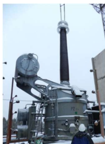
Рис. 1. Шунтирующий реактор РОДЦ-60000/500
