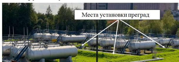
Рис. 4. Места установки преград между группами резервуаров на обвалованиях
