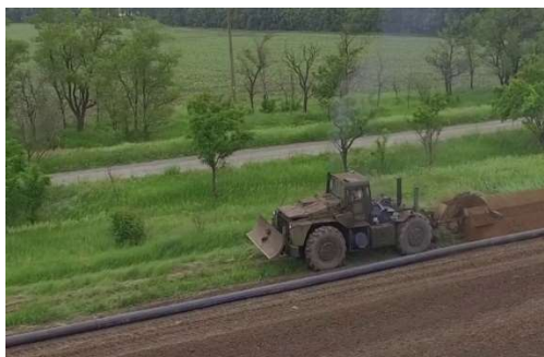
Рис. 3. Бульдозер БКТ-рк2 прокладывает опорную минерализованную полосу
