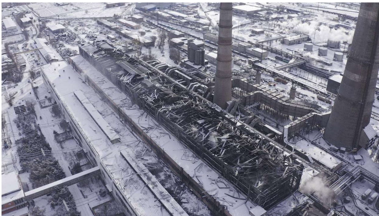
Рис. 1. Характер повреждений при взрыве на Бишкекской ТЭЦ
