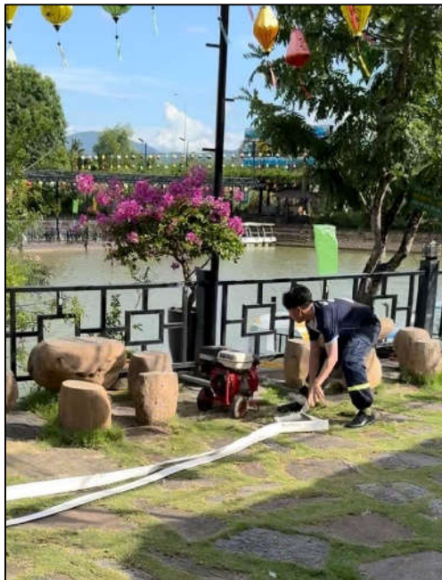
Рис.6. Установка мотопомпы пожарной на водоисточник для забора и подачи воды на нужды пожаротушения
